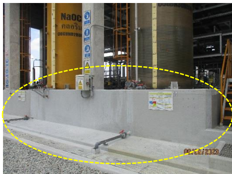
ภาพที่ 2.2-33 คันคอนกรีตรอบถังเก็บสารเคมี
