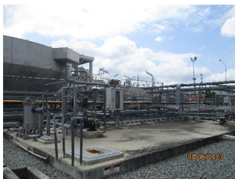
ภาพที่ 2.2-15 บ่อปรับสภาพความเป็นกรด-ด่าง (Neutralization Pit)
